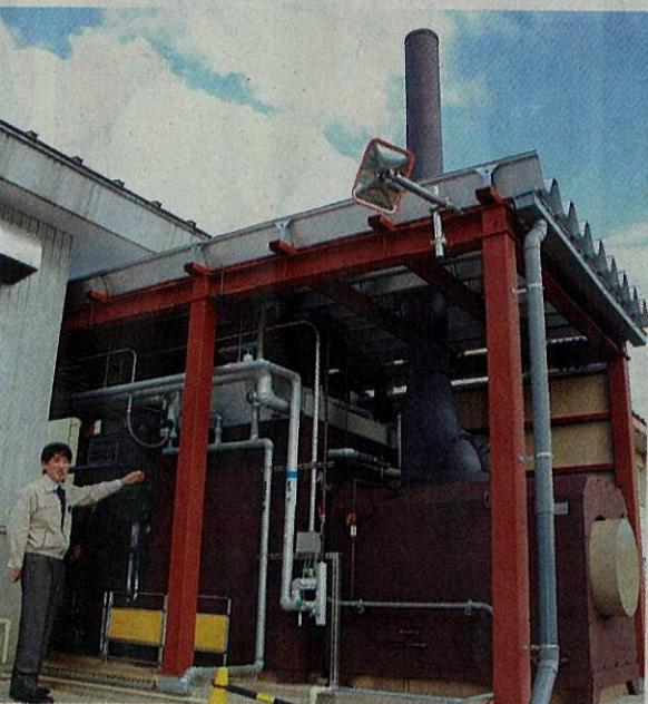
フロスを燃料とするバイオマスボイラー（十日町市高山のミートコンパニオン新潟第二工場で）
